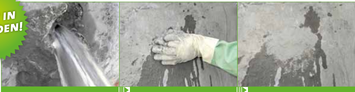
Een actieve lekkage is direct afgedicht met Köster Kelderdicht
