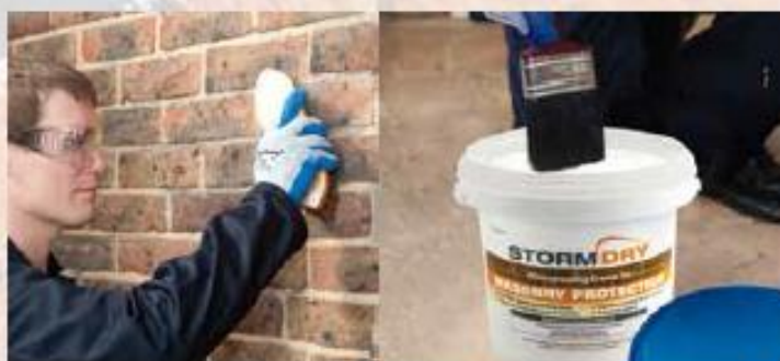
Voorbereiding van het metselwerk
